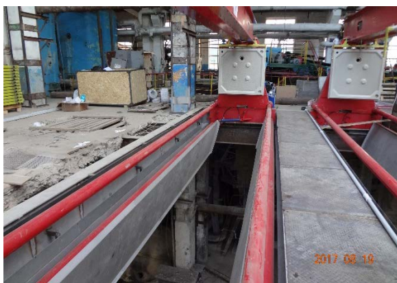
Rys. 1. Początek montażu pras filtracyjnych
